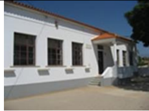
EB 1 da Estação
