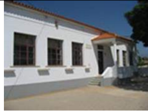
EB 1 da Estação
